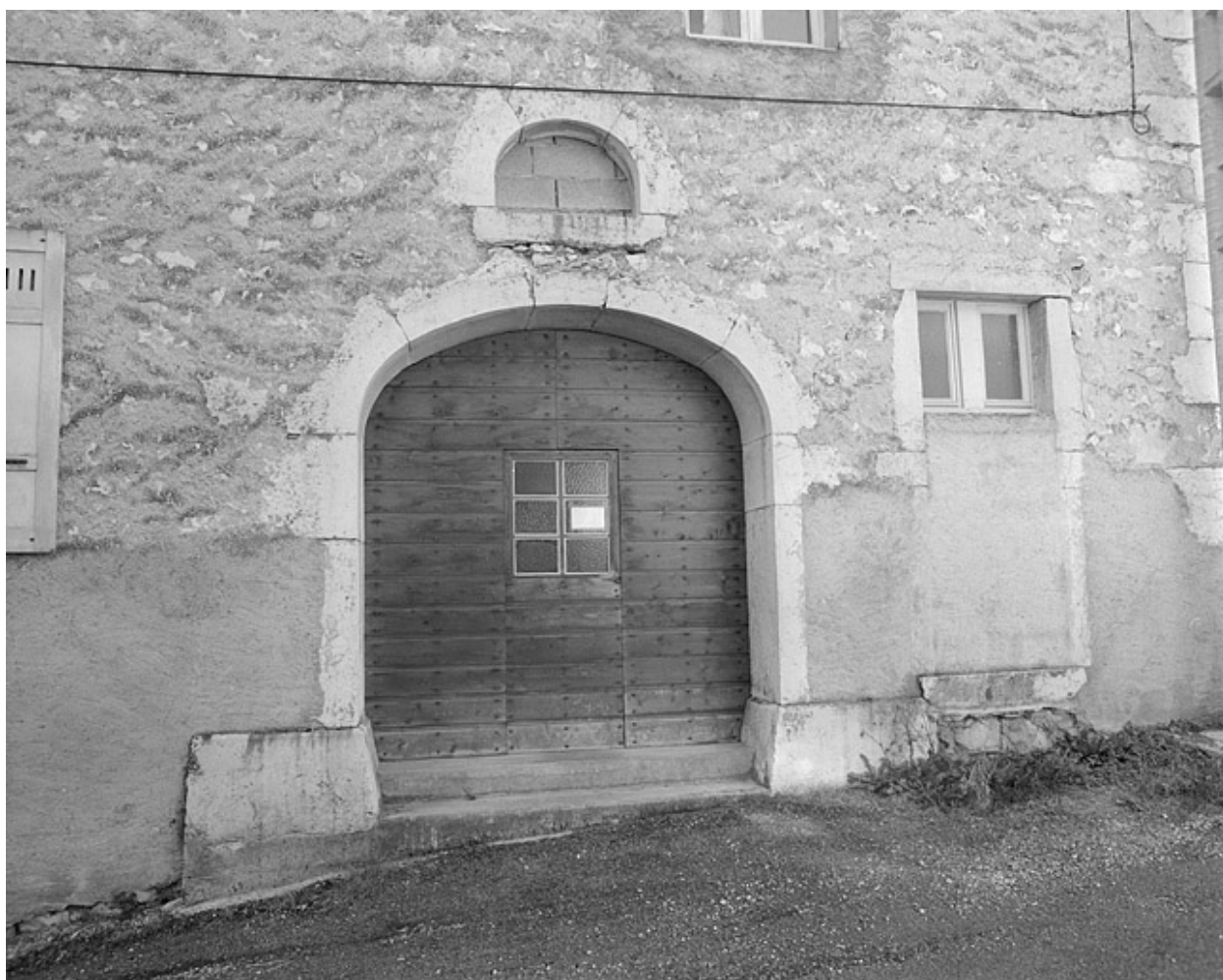
Bureau : porte dans le mur pignon nord-ouest.
