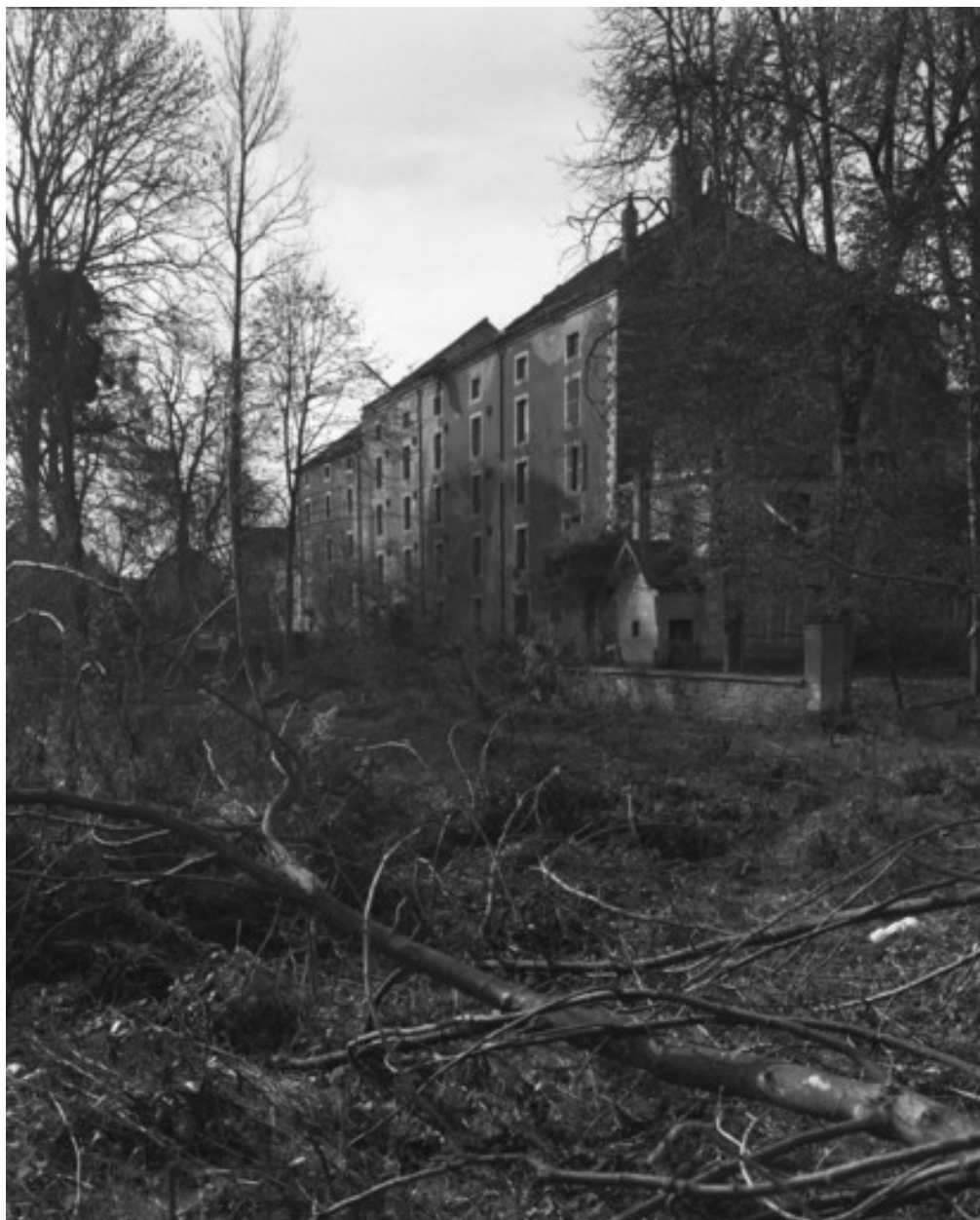
Façade postérieure du moulin public en 1989.
