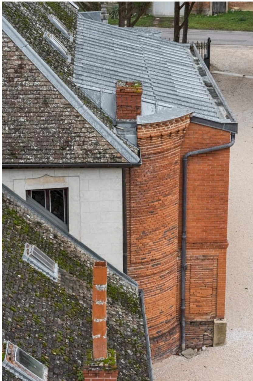
Toiture du foyer (corps nord), depuis le "Donjon".
