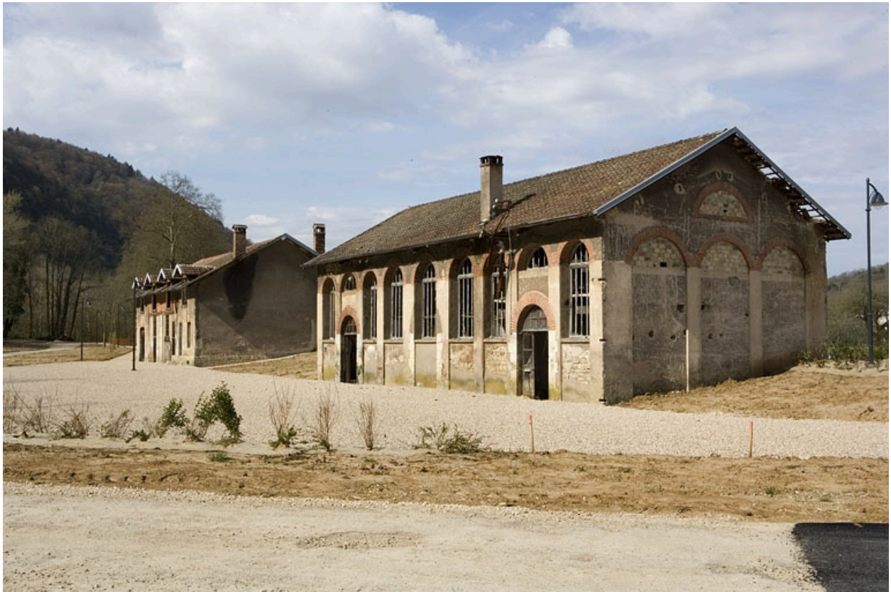
Vue de trois quarts droite de l'atelier de réparation et de l'écurie.
