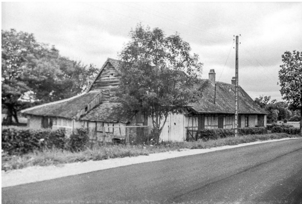
Ferme : vue générale.
