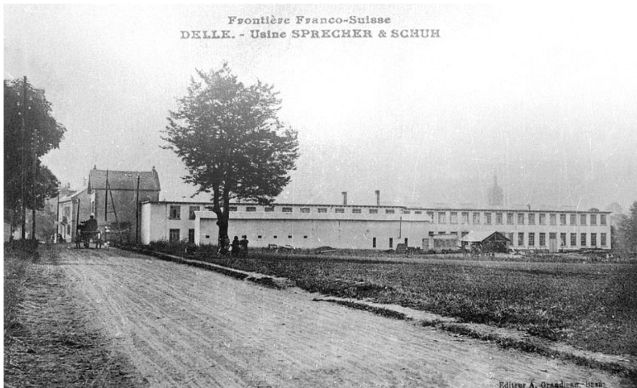
Delle. - Usine Sprecher & Schuh.
