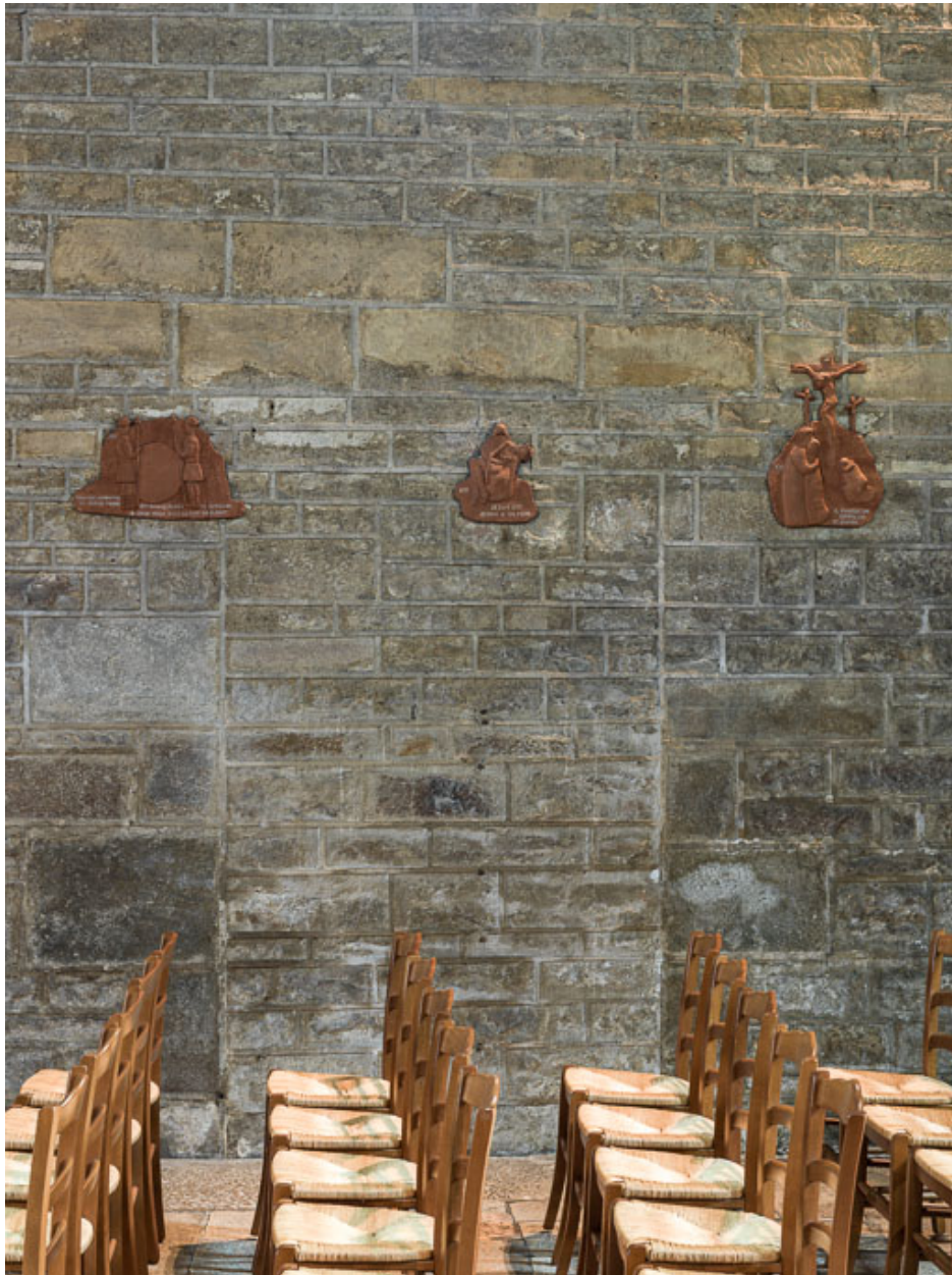
Porte murée, bras nord de la nef.
