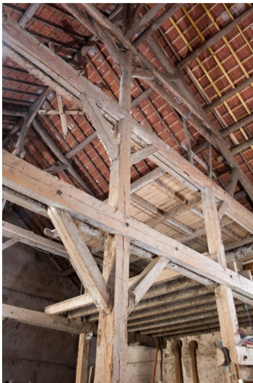
Grange : vue de la charpente.
