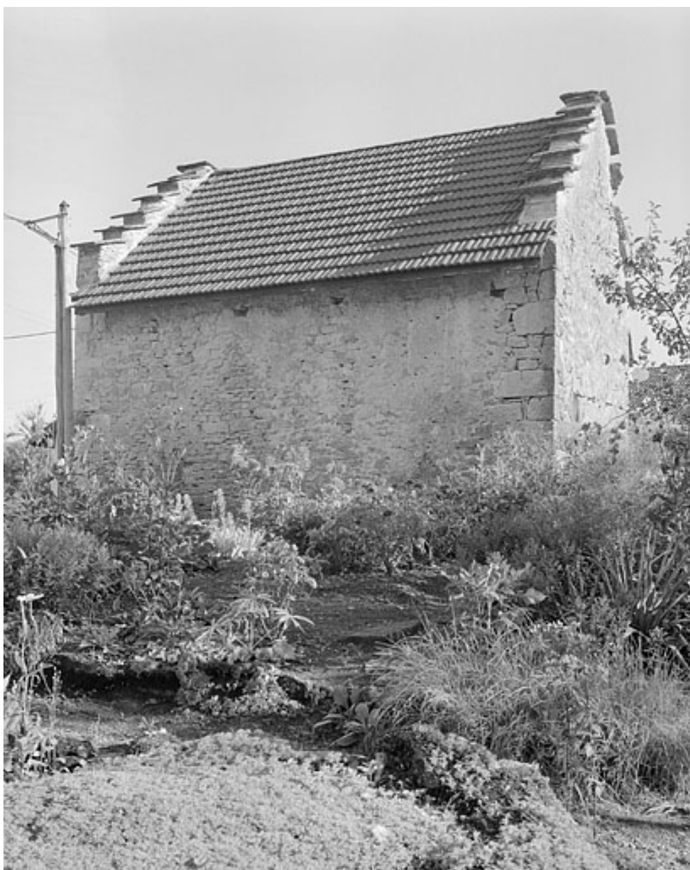
L'ancienne fromagerie de Ponthoux, face sud.
