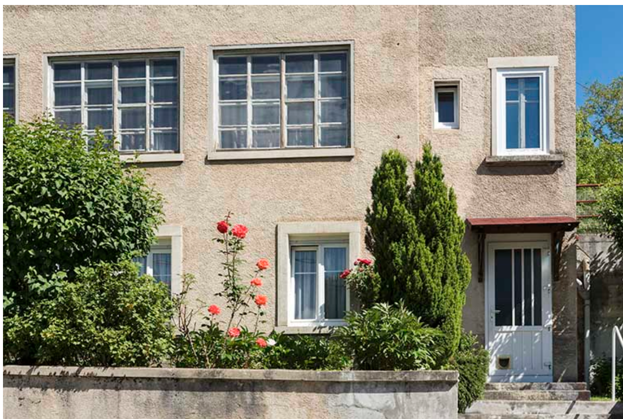
Façade sud : entrée à droite.
