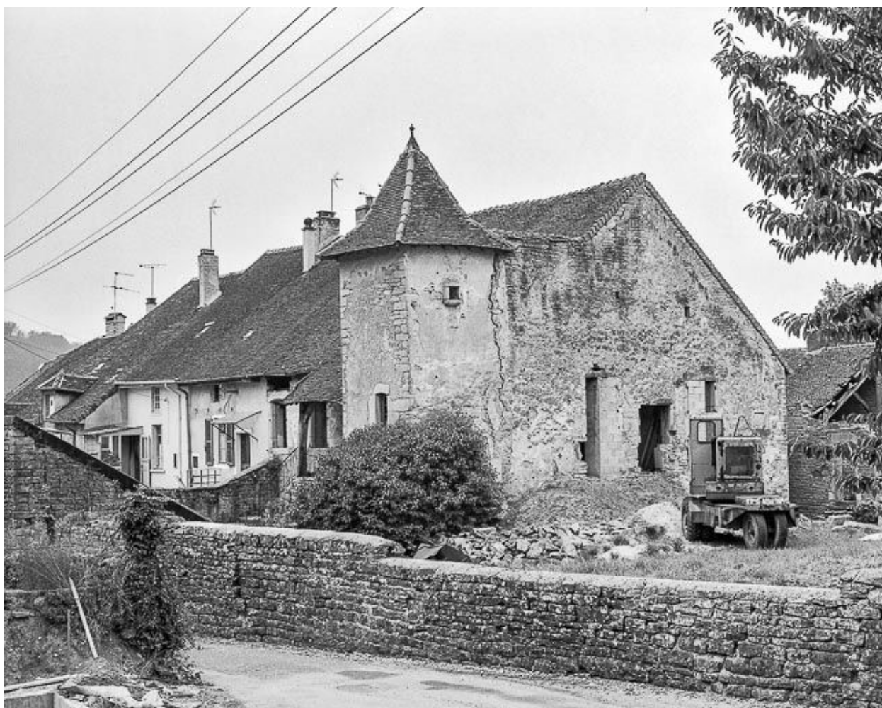
Maison de vigneron située place Jean-Moulin.
