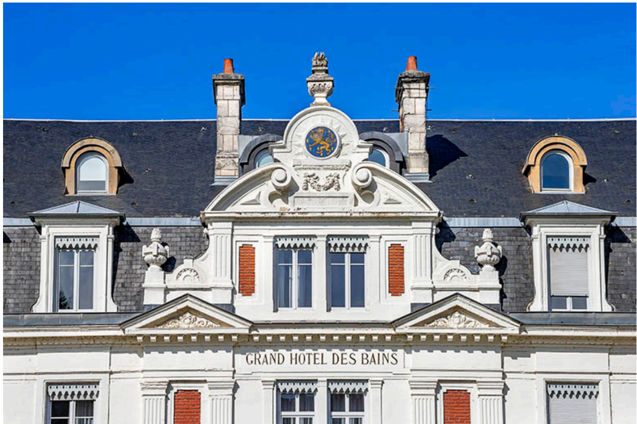
Façade sur le jardin, travées centrales, médaillon aux armes de la Franche-Comté.
