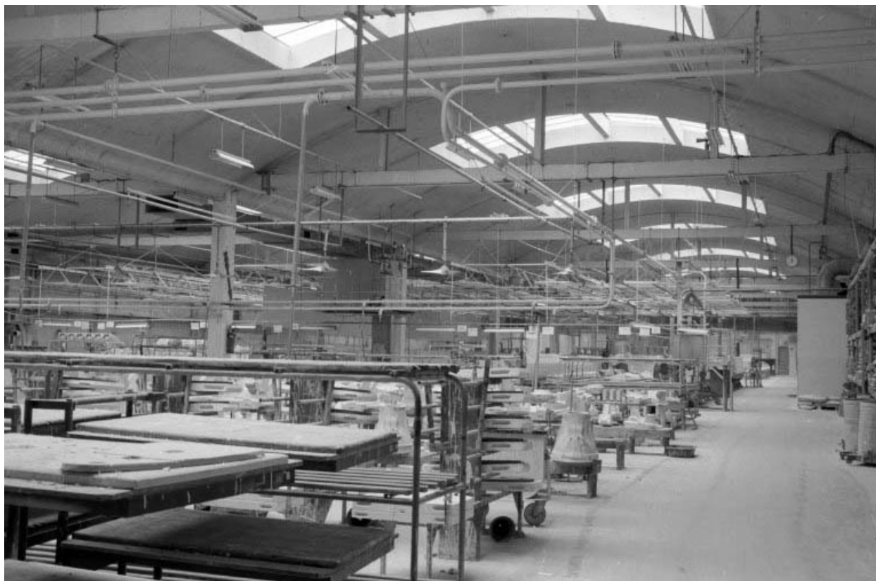
Atelier de coulage C (9), intérieur.
