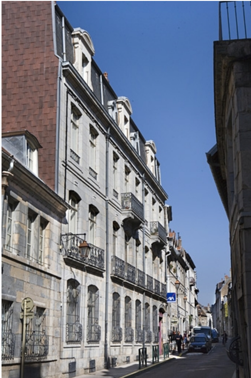
Vue d'ensemble du logis principal sur rue, de trois quarts gauche.
