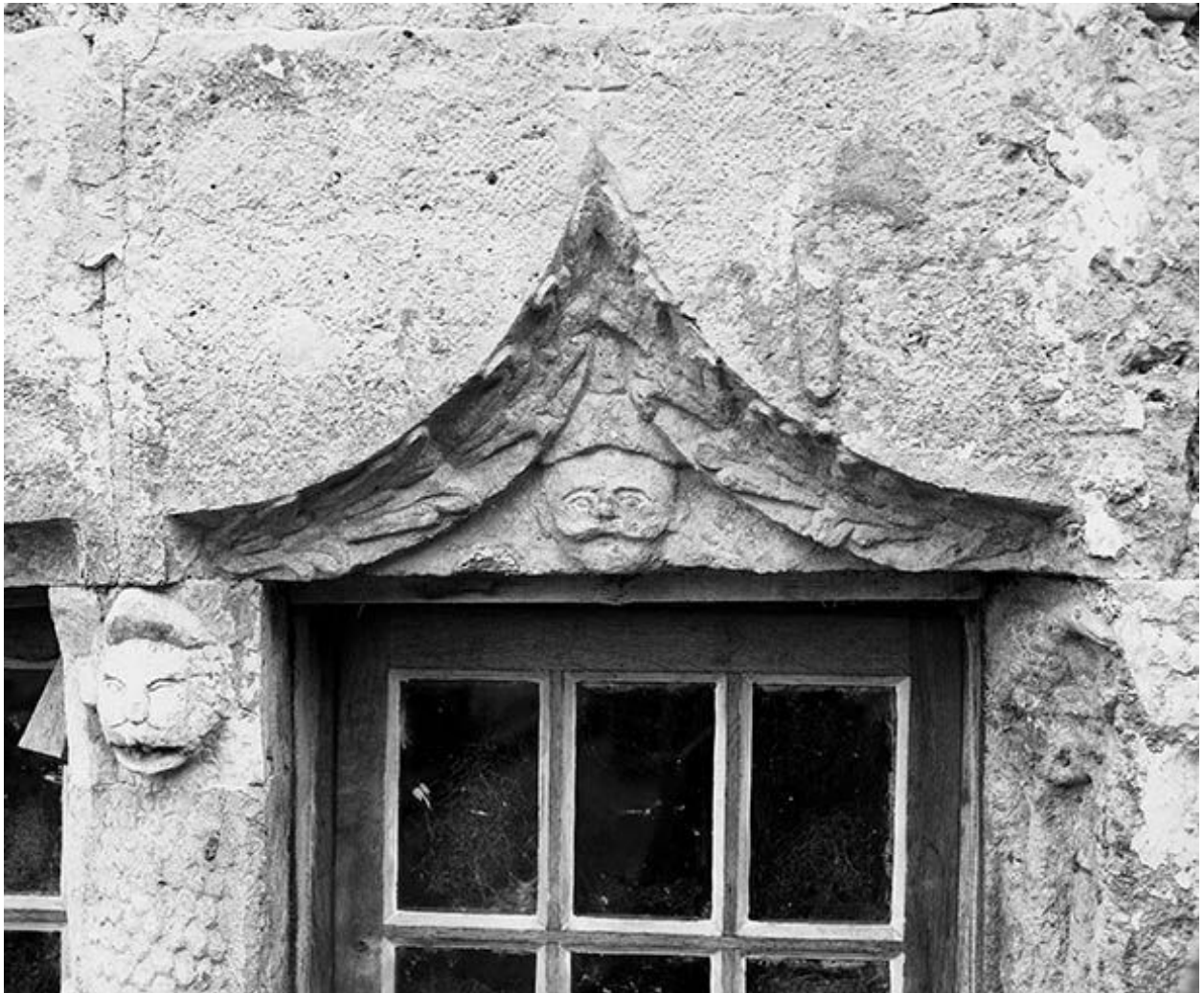
Détail du linteau de la baie gauche du rez-de-chaussée, côté cour.
