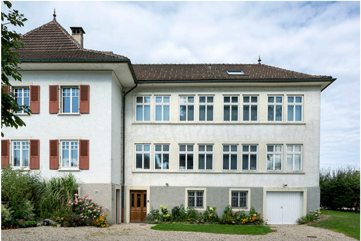
Usine : façade antérieure.
