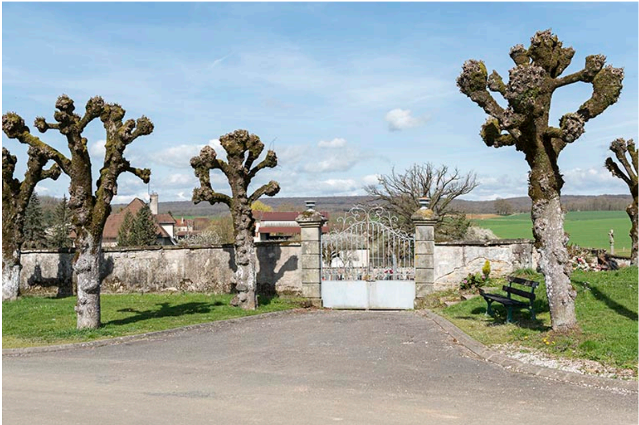
Grille d'entrée et mur d'enceinte du cimetière.
