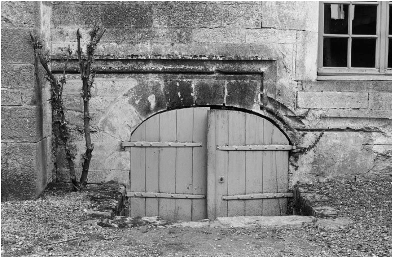
Porte de cave (corps de logis) (photo prise en 1969).
