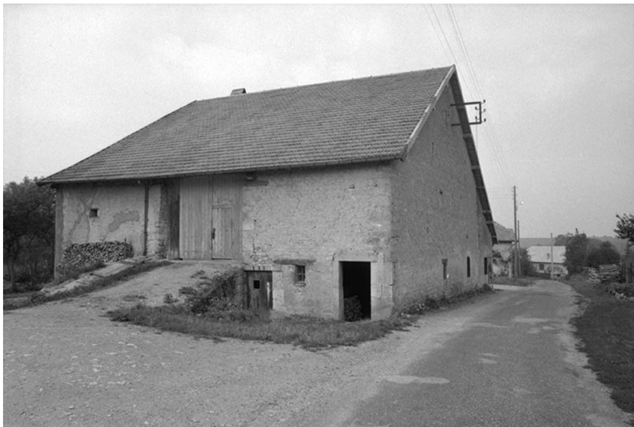
Ferme située rue de l'Abreuvoir.
