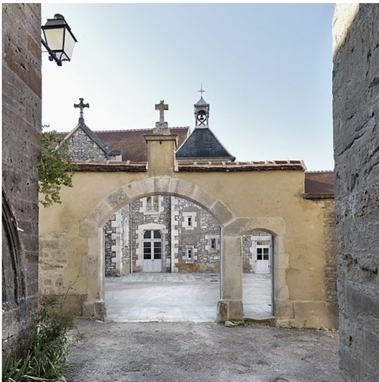
Vue d'ensemble depuis la rue du Couvent.
