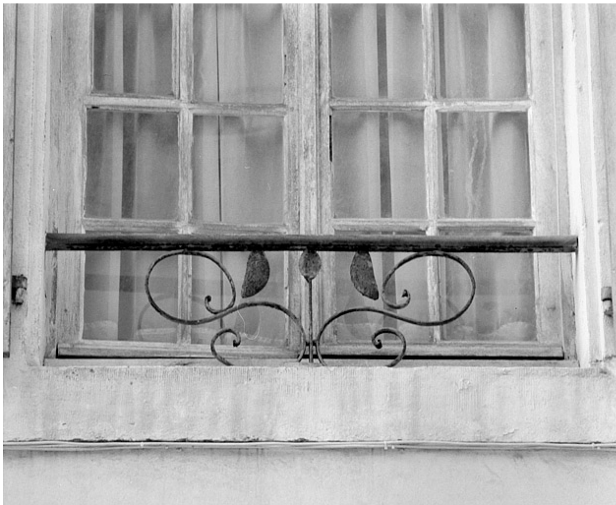
Façade sur rue. Détail d'un balconnet.
