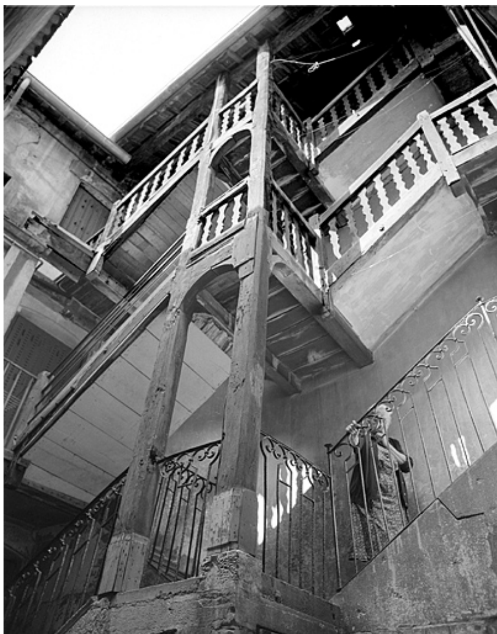
Escalier dans la cour.
