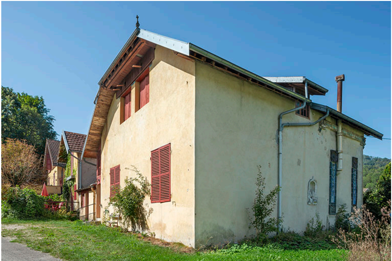
Vue de trois quarts depuis le chemin de Prailles.
