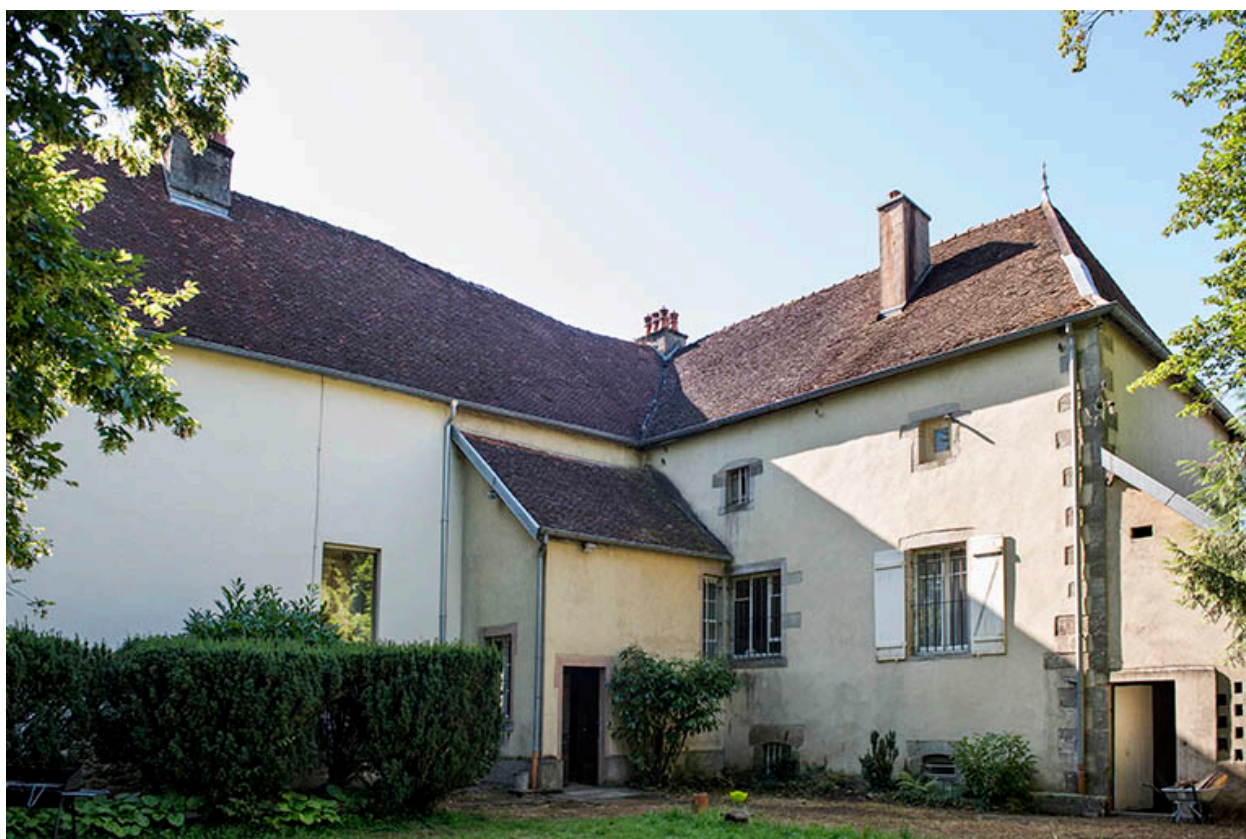
Les façades postérieures vues du nord.
