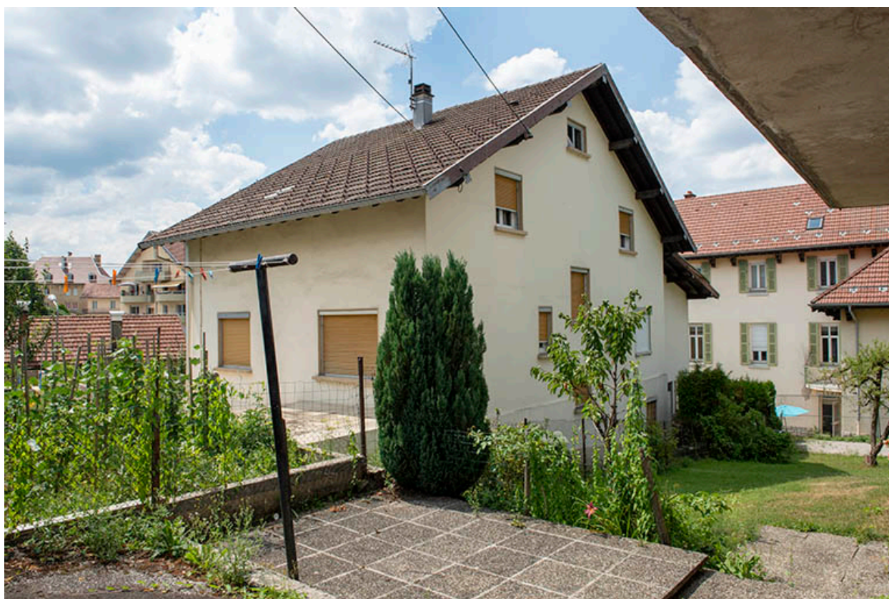
Maison : façades postérieure et latérale droite.
