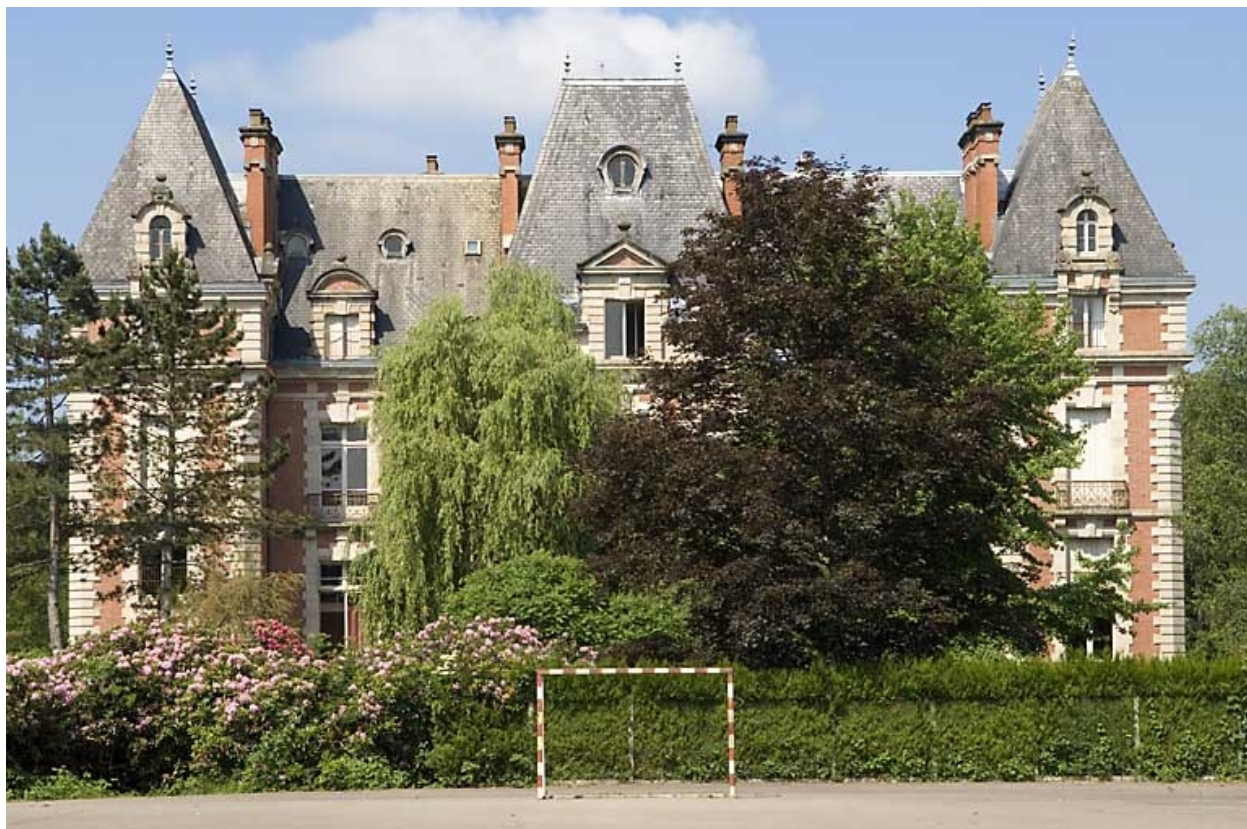
Logement patronal. Façade antérieure.
