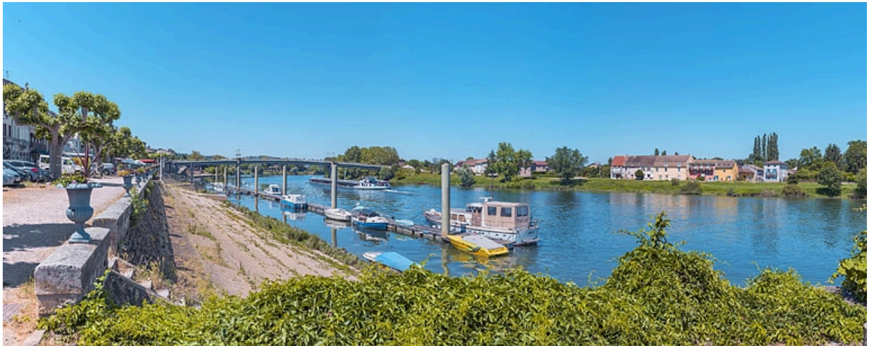
Vue d'ensemble des quais à gradins.
