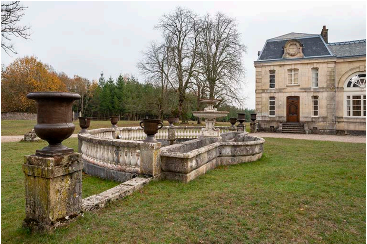
Fontaine et abreuvoir dans la cour de l'écurie, vue depuis le nord.
