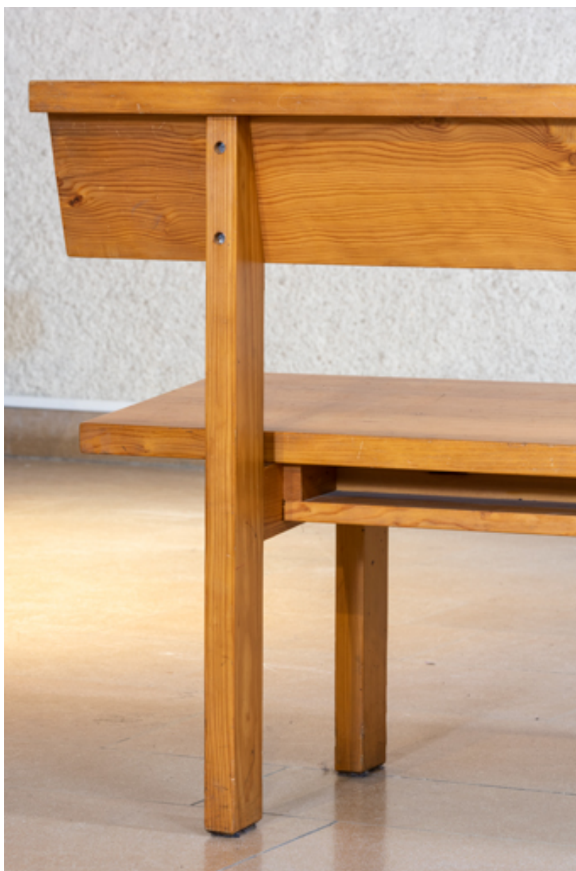
Détail de l'extrémité du banc de temple.
