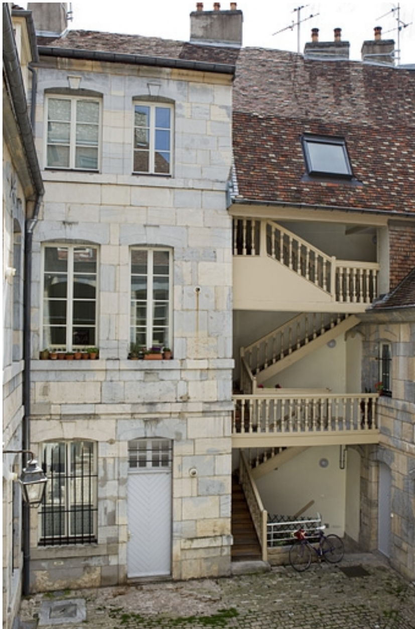
Vue d'ensemble du logis secondaire gauche et de l'escalier à cage ouverte sur cour.
