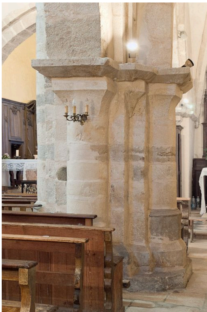
Deuxième pilier entre la nef et le bas-côté droit, vue antérieure.
