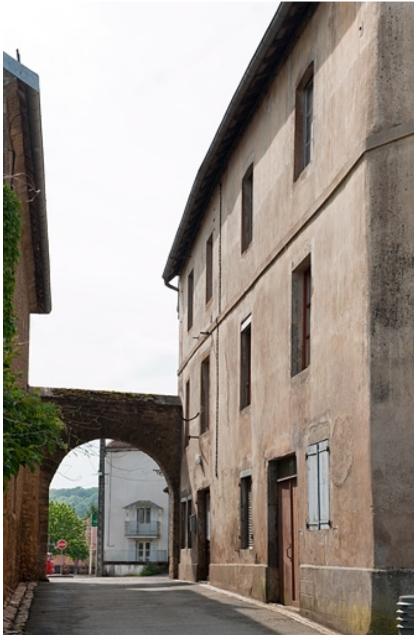
Vue de la porte du Vieux-Moulin et de la façade antérieure de l'hôtel.
