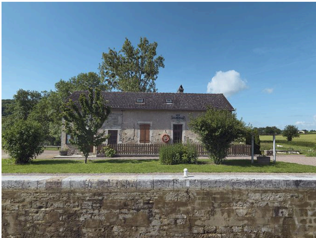
Maison éclésièr de face.
