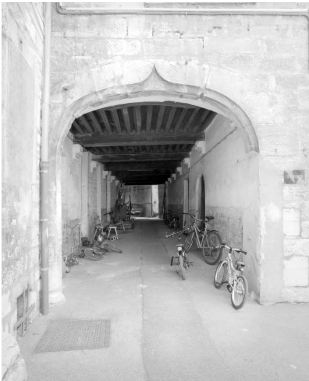
Passage dans la deuxième cour : vue d'ensemble.
