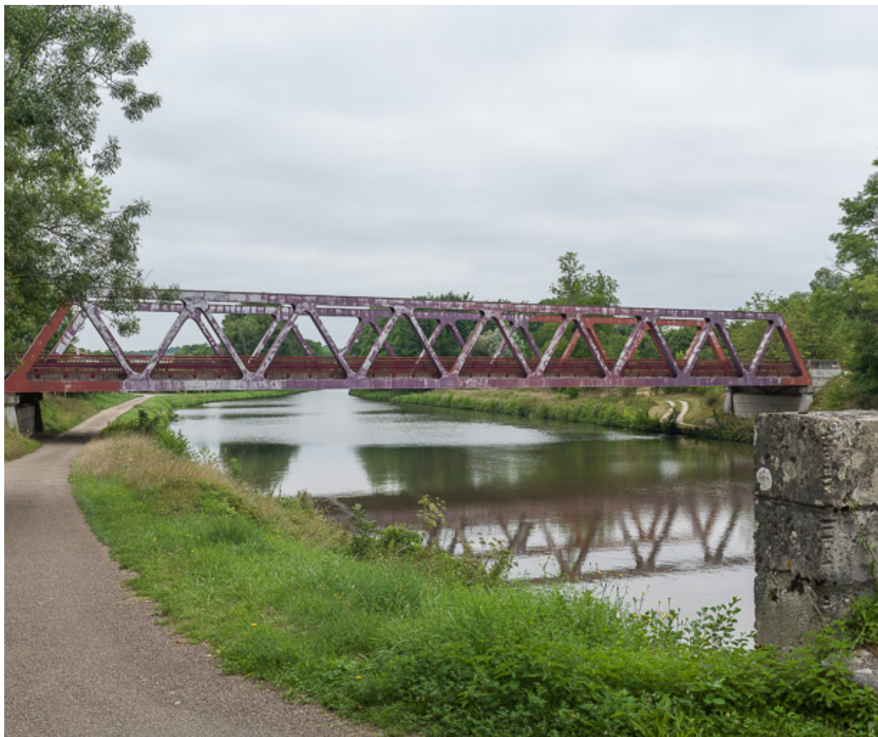
Vue du pont.
