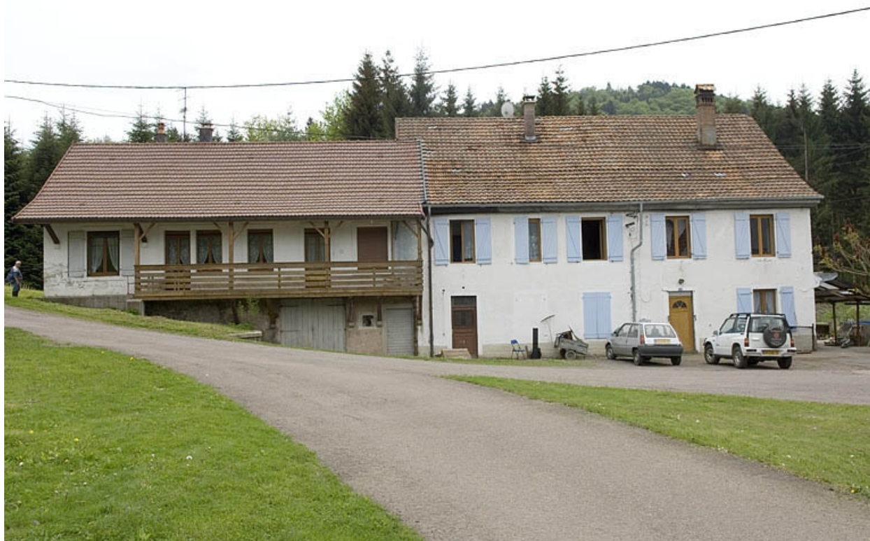
Logement ouvrier et patronal.
