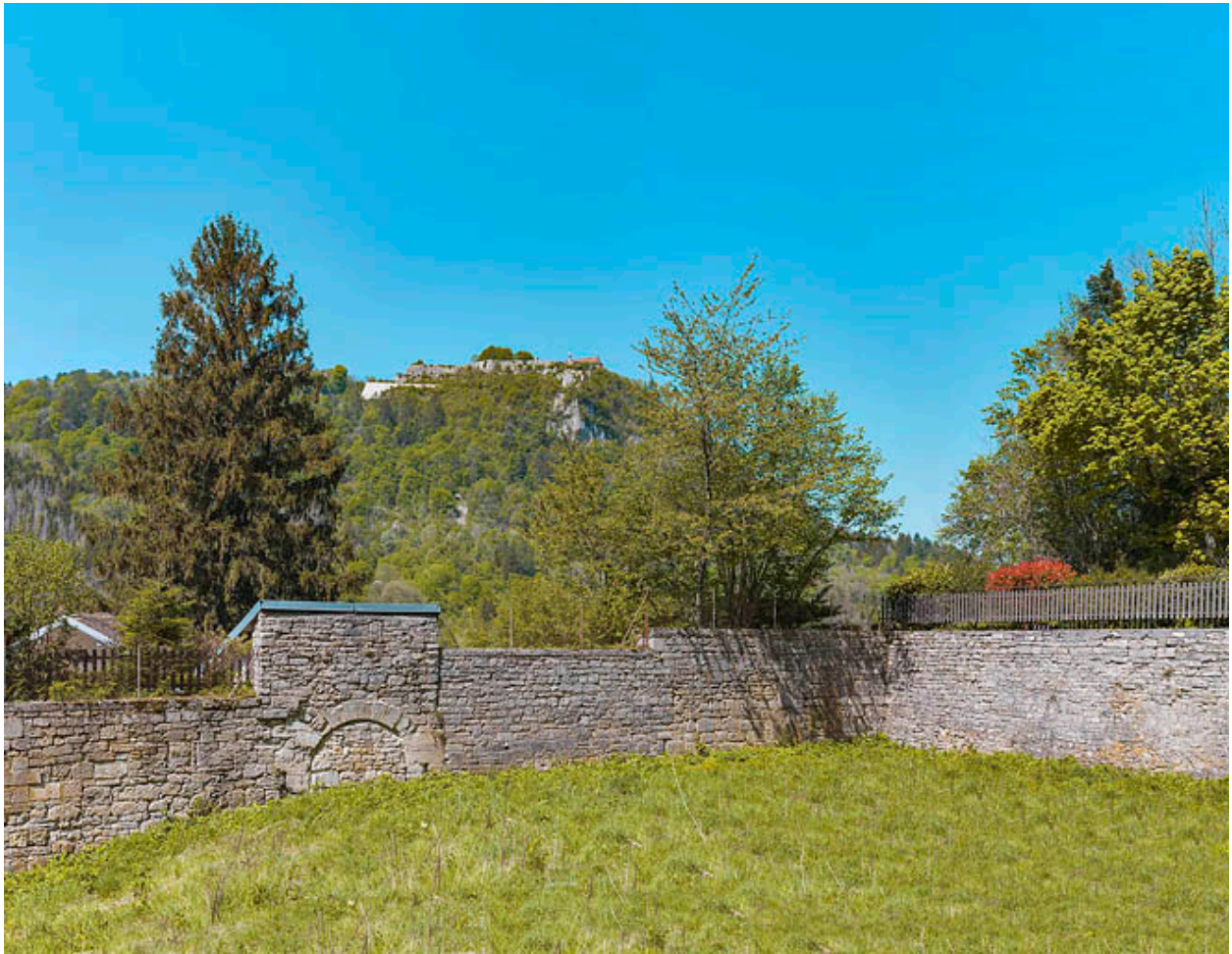
Rempart est, et poterne (murée) de Châtelguyon.
