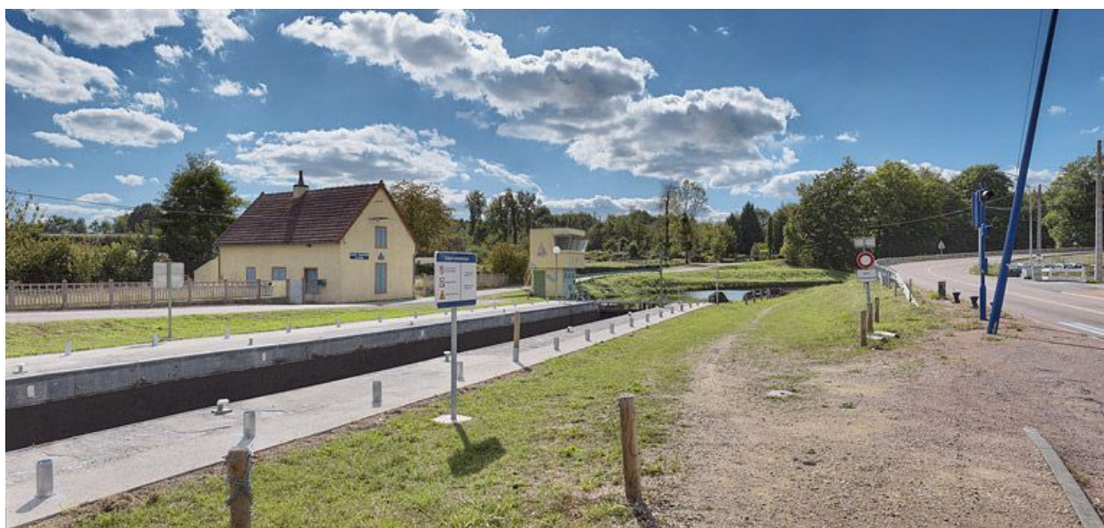
Site d'écluse pris d'aval.
