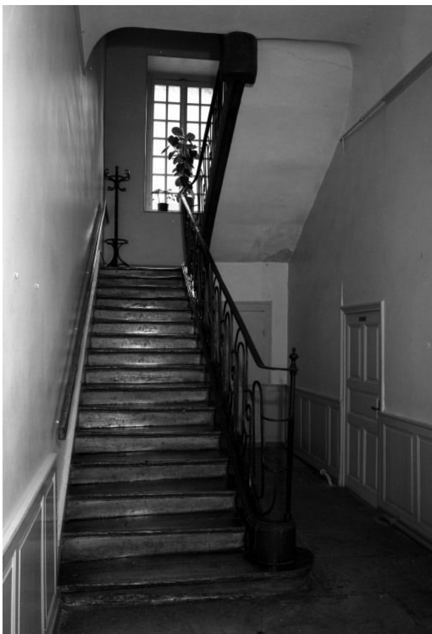
Escalier, première volée.
