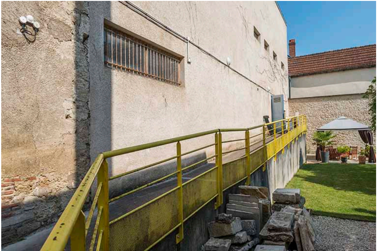
Façade est et organe de circulation extérieure de la cantine.
