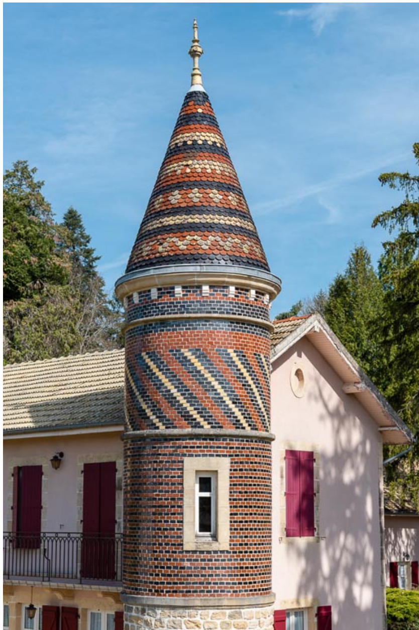
Détail de la tourelle d'angle.
