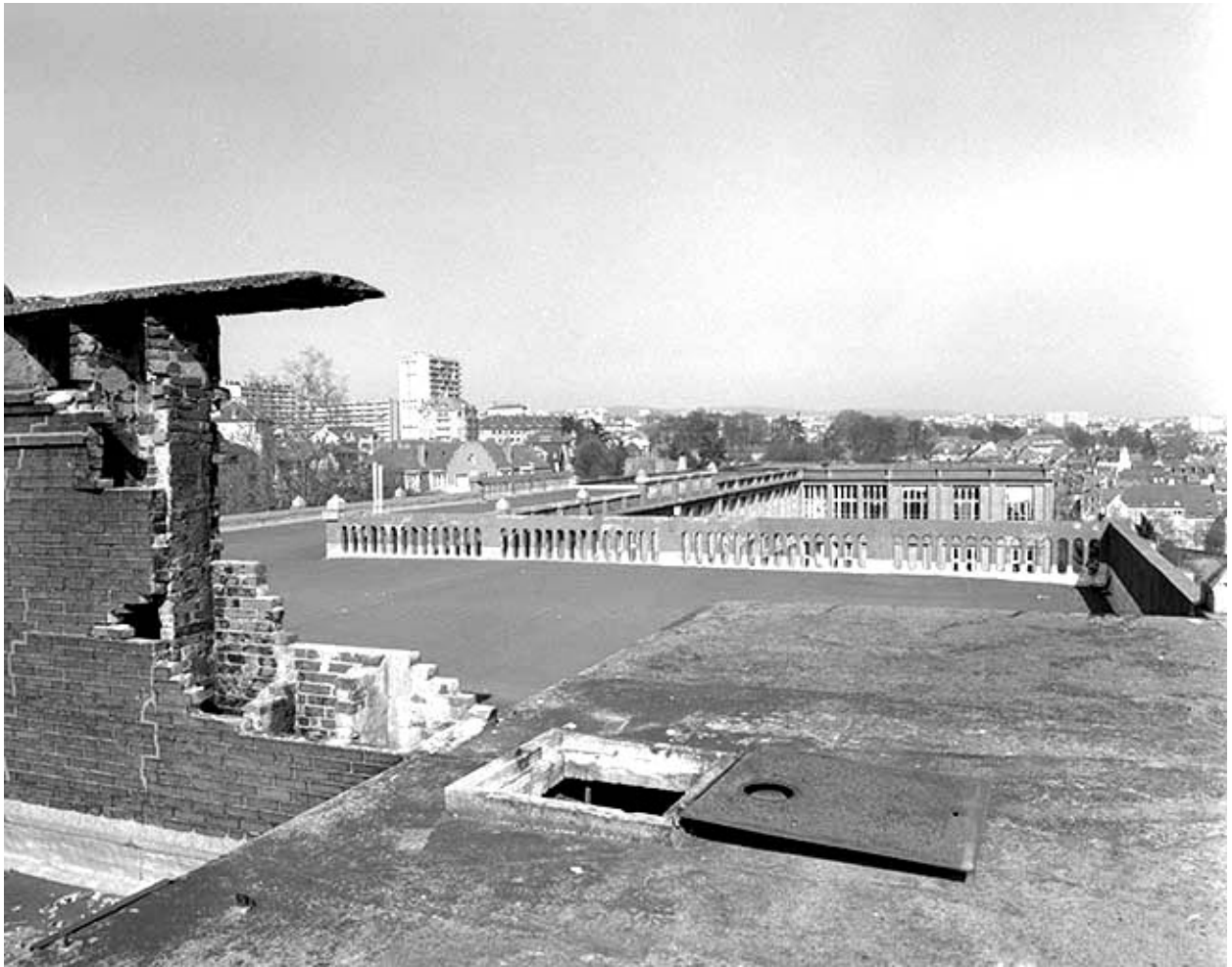
Toit terrasse des bâtiments (6, 8, 9).
