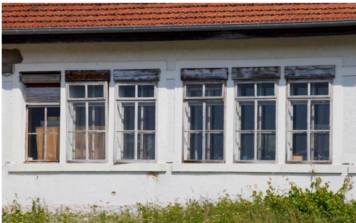
Détail des fenêtres de l'atelier.
