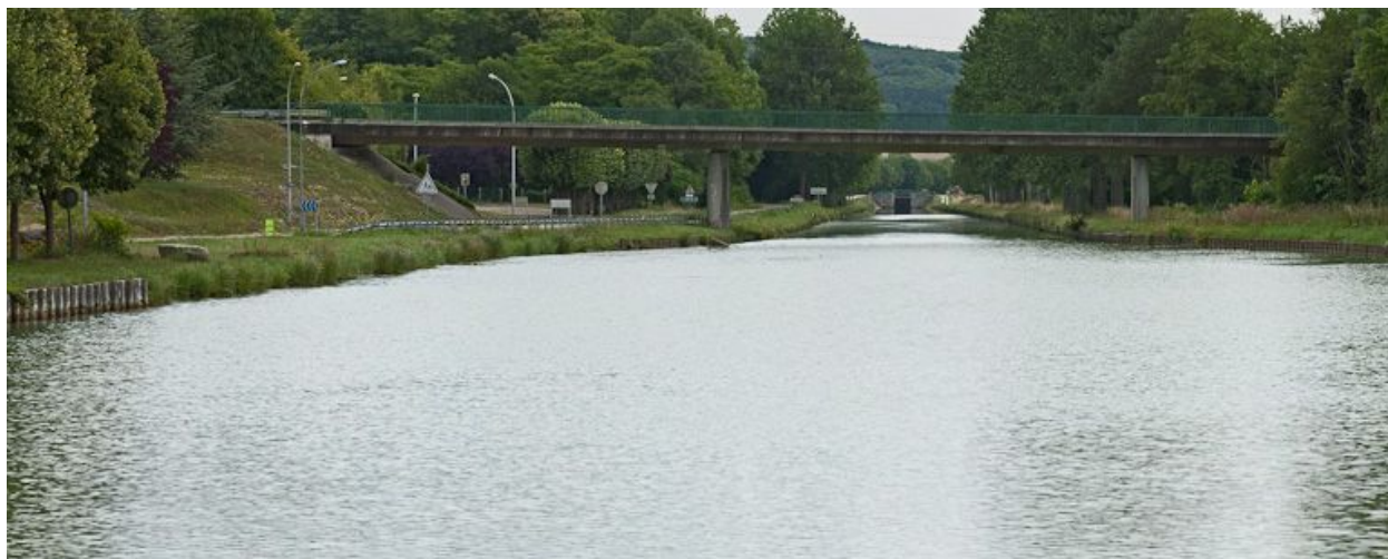
Vue du pont.
