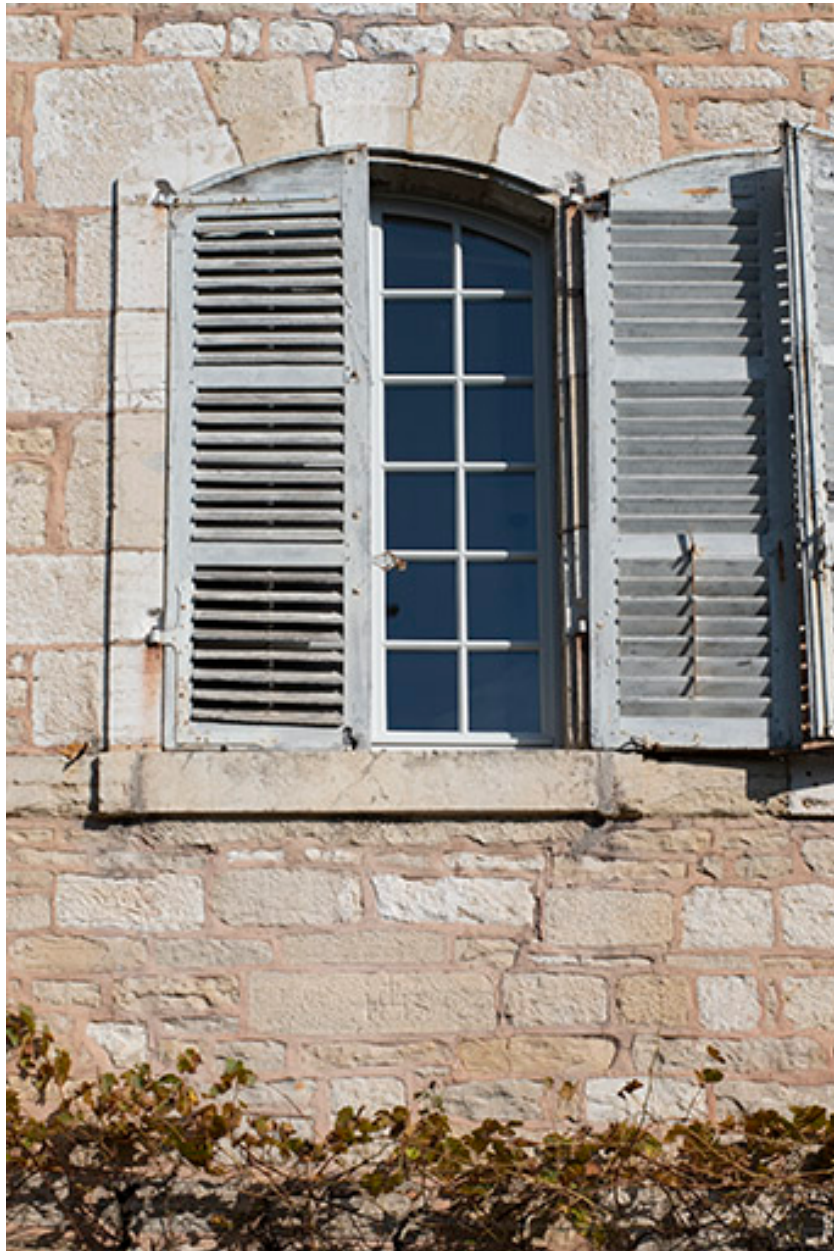
Fenêtre du rez-de-chaussée (façade ouest).
