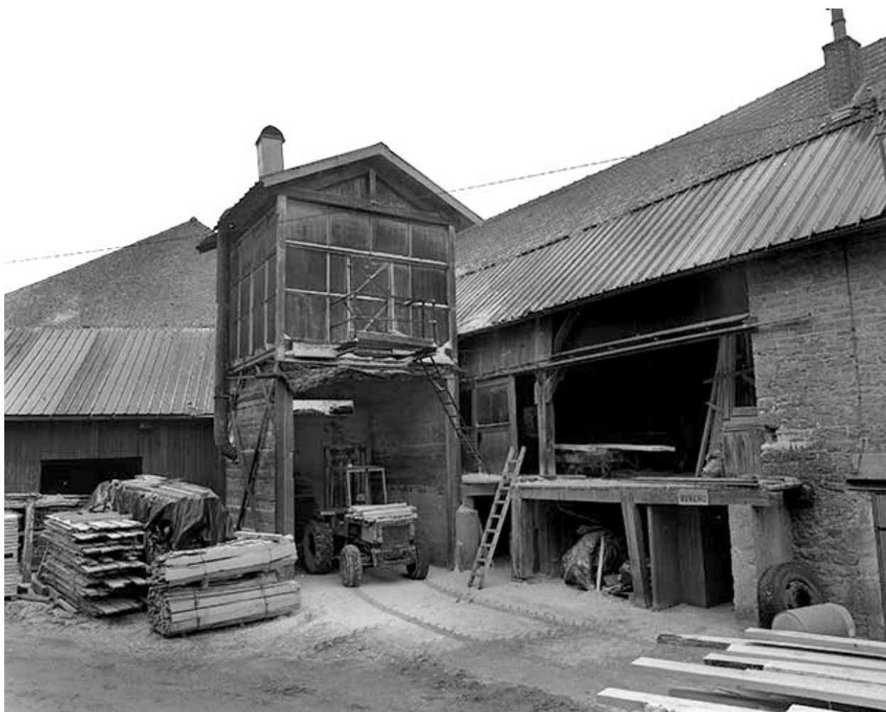
Silo à sciure et atelier de fabrication.
