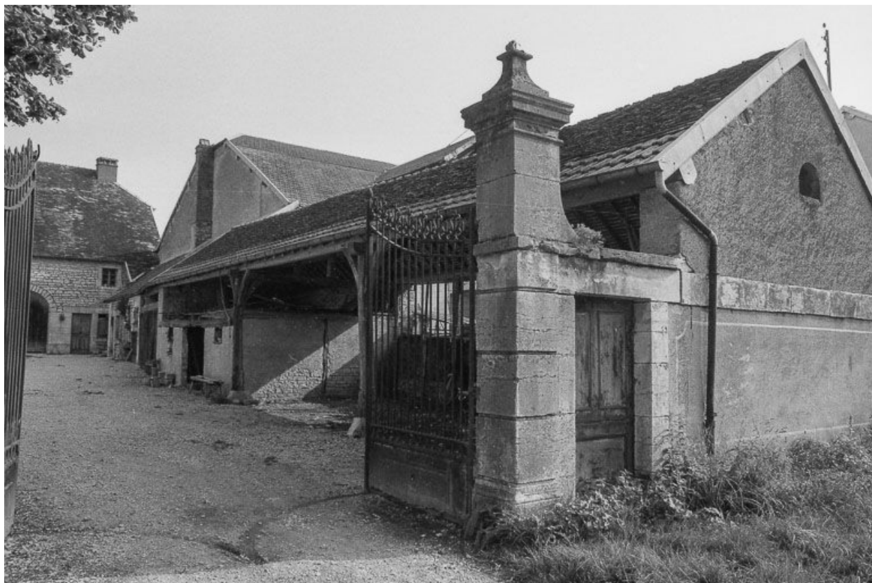
Remise sur le côté droit de la cour.
