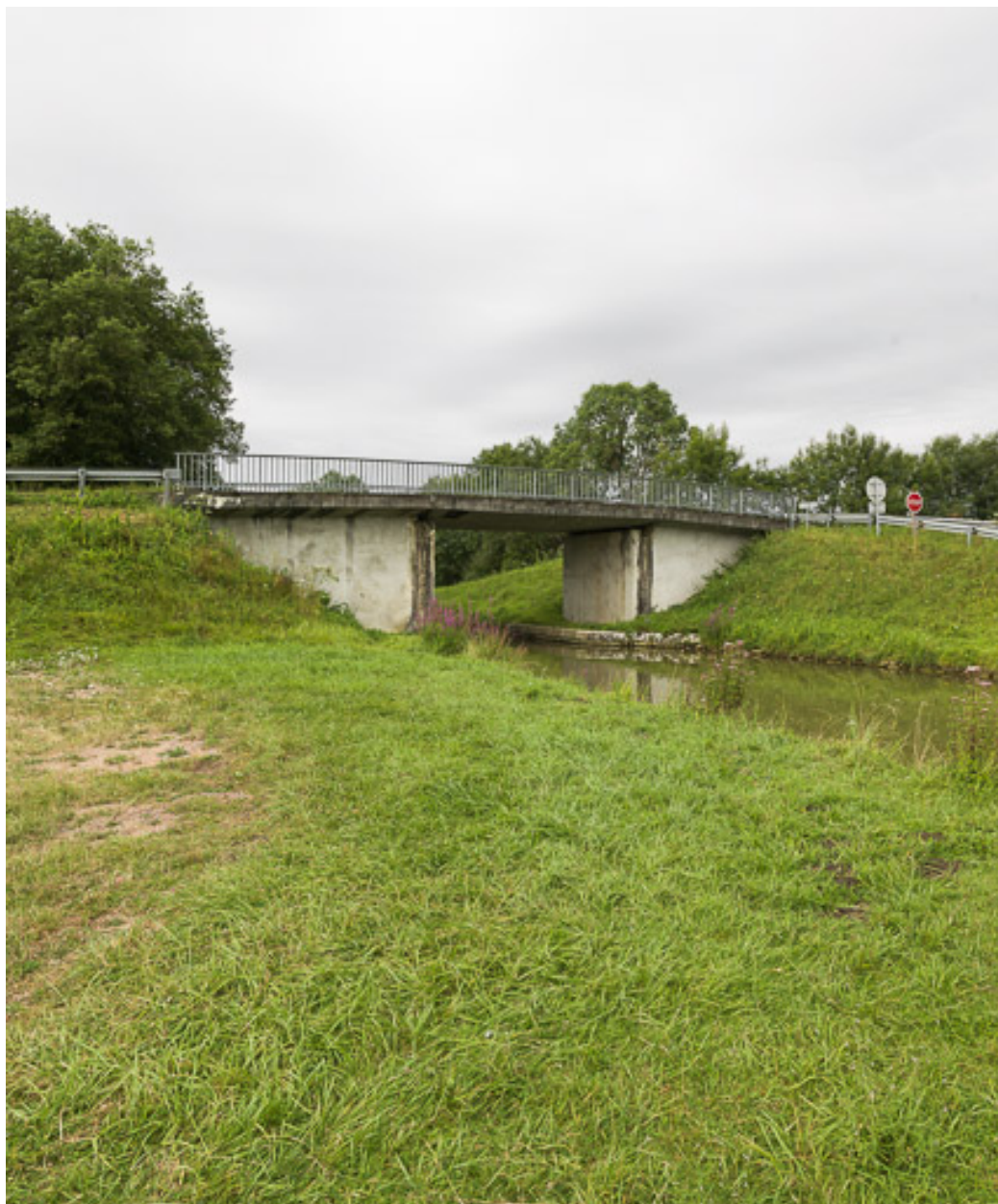
Vue d'ensemble du pont.
