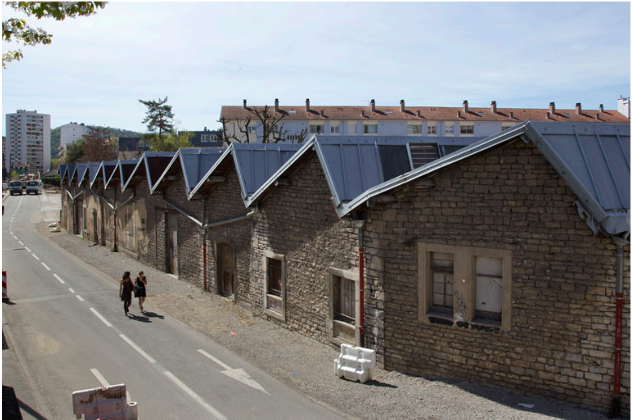
Atelier de fabrication boulevard Diderot : pignons des sheds, depuis le nord.
