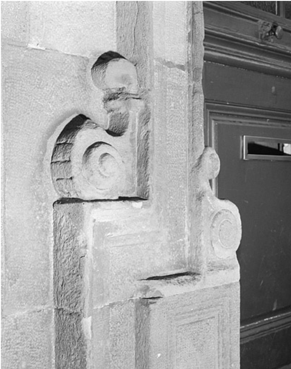
Façade principale. Détail de la porte centrale.
